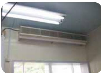
◀ 1. エアーカーテン（トイレの入り口上部に設置します。空気のドアでトイレ内の臭いを遮断します）
