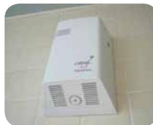
◀ 2. エアーフレッシュナー（トイレ内上部に設置し、箱内のファンが電池により定期的に作動します。脱臭と芳香を同時に行います）
